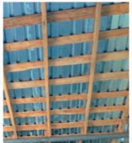
არასათანადო ხის ჭერი: ხის მასალა სათანადოდ ვერ სუფთავდება და ლარებში მტვერი და წუჭყი შეიძლება დაგროვდეს
